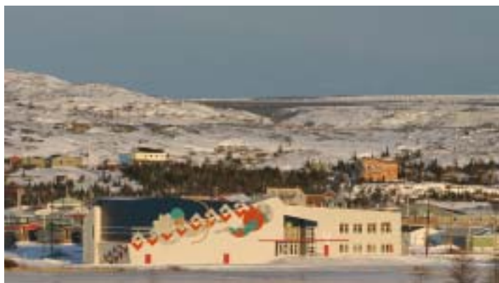
Hôtel de ville de Katittavik | Architecte : Fournier Gersovitz Moss & Associés Architectes / Photo : Heiko Wittenborn
