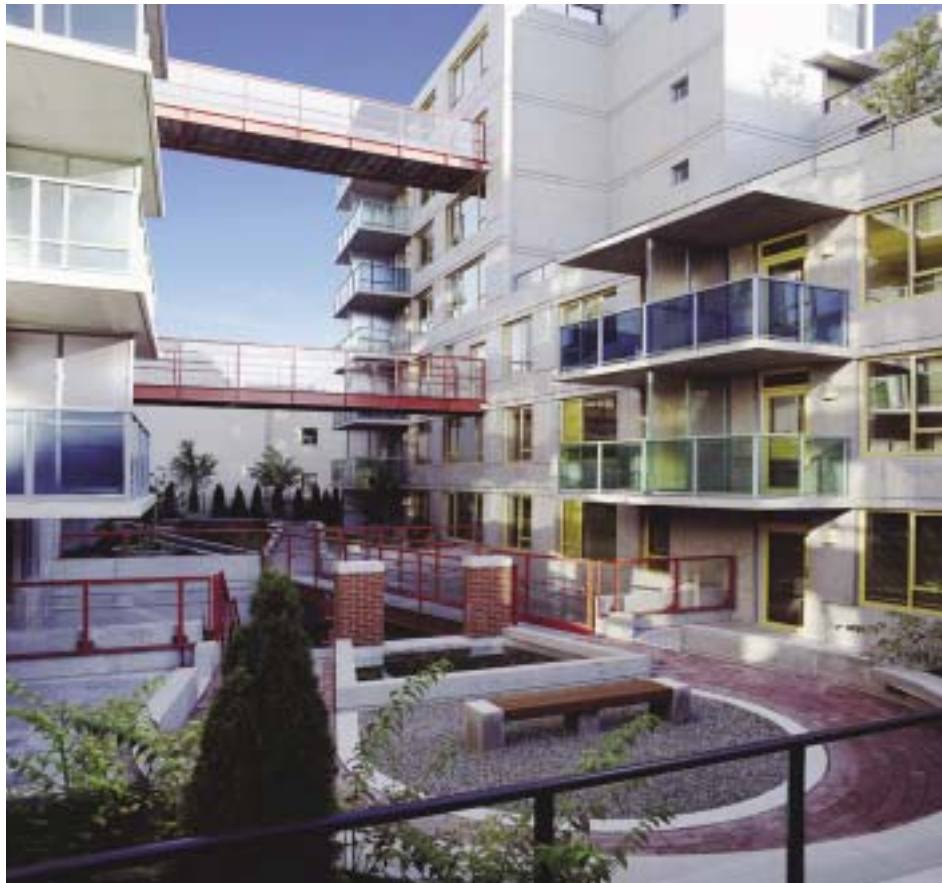
Coopérative d'habitation Lore Krill | Architecte : Henriquez Partners Architects | Photo : Derek Lepper
