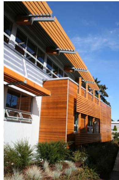
Centre des opérations de la Réserve de parc national du Canada des Îles-Gulf | architecte : Larry McFarland Architects Ltd. | photo : Derek Lepper
