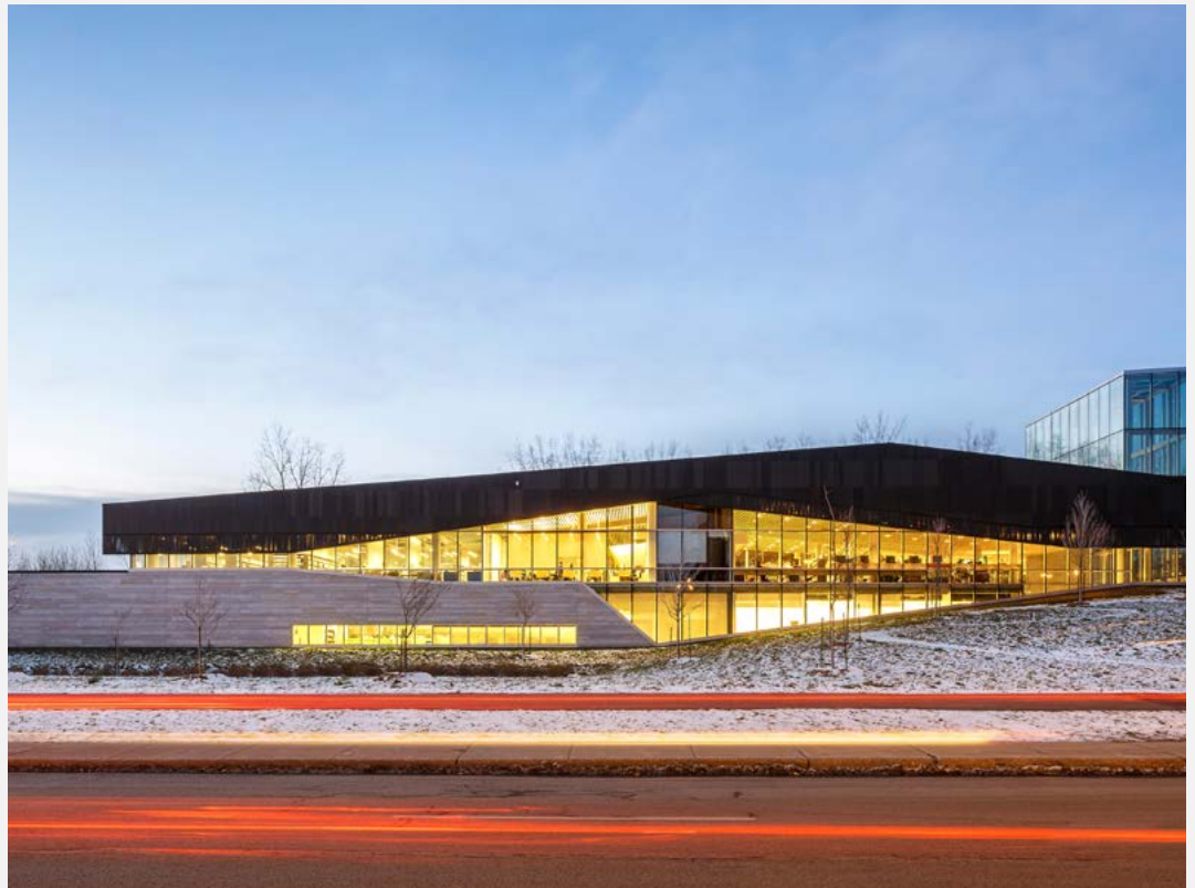
| VUE DU BOULEVARD THIMENS
