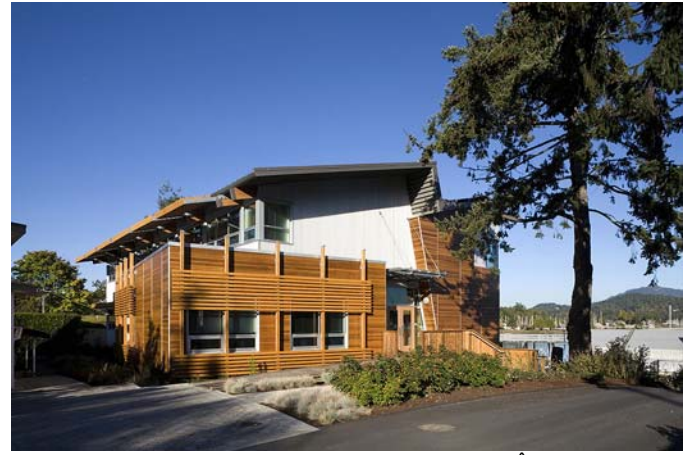
Centre des opérations de la Réserve de parc national du Canada des Îles-Gulf | photo : Derek Lepper
