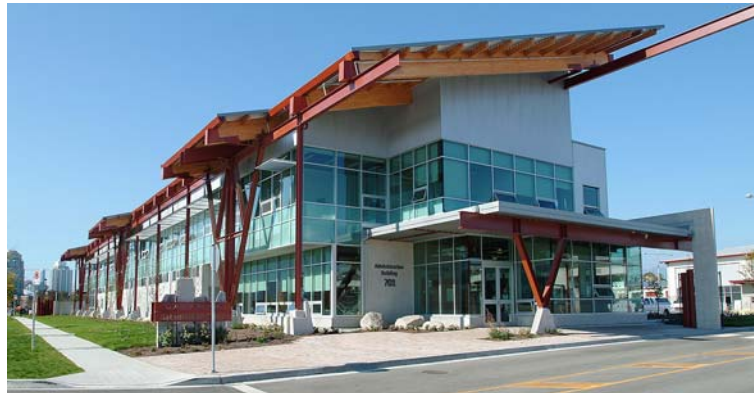
City of Vancouver National Works Yard, Certifié Or en vertu de LEED 2.1 du CBDCa | Omicron Architecture Engineering Construction Ltd. | photo : Terry Guscott
